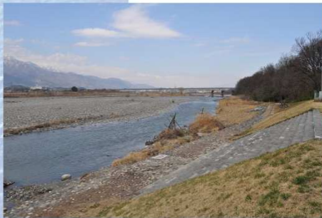
▲信玄堤から見る釜無川
